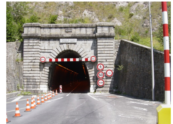
Tunnel du Lioran; Source: CETU
